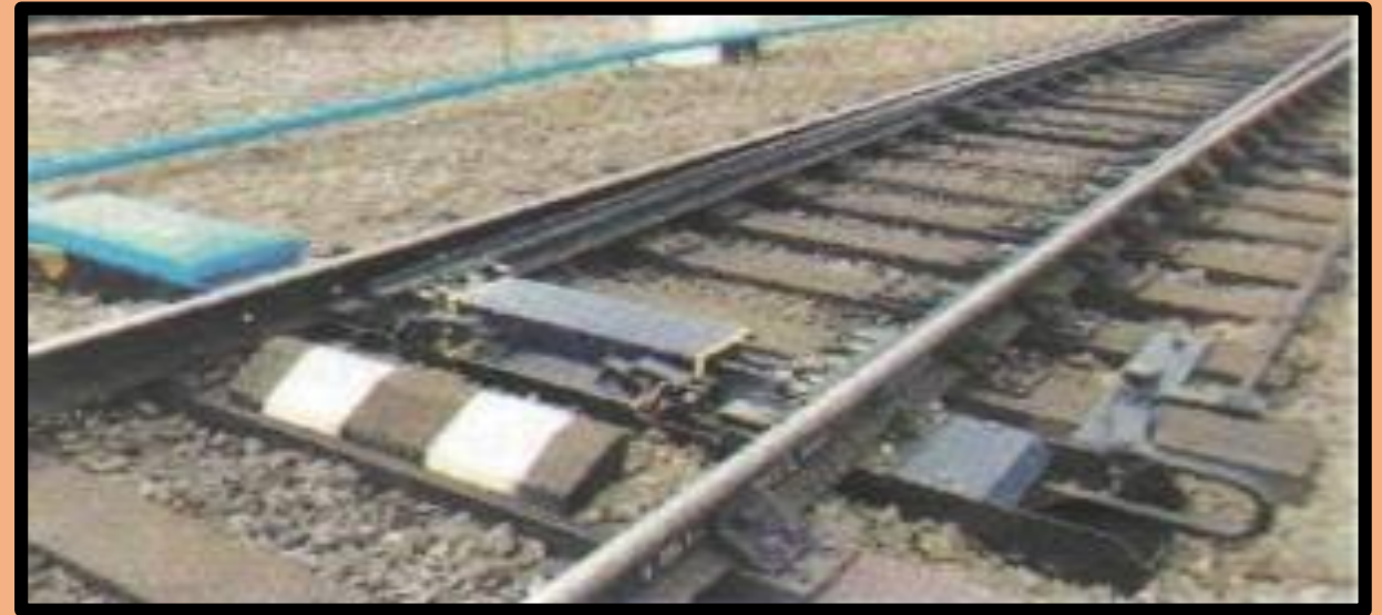
Для движения подвижного состава со скоростью более 160км/ч для стрелочных переводов требуются внешние замыкатели и устройства контроля прижатия остряка к рамному рельсу и подвижного сердечника к усовику крестовины
